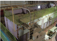
乾燥炉扉の外張り断熱
